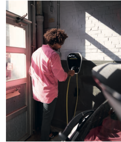
MINI WALLBOX INSTALLATION
